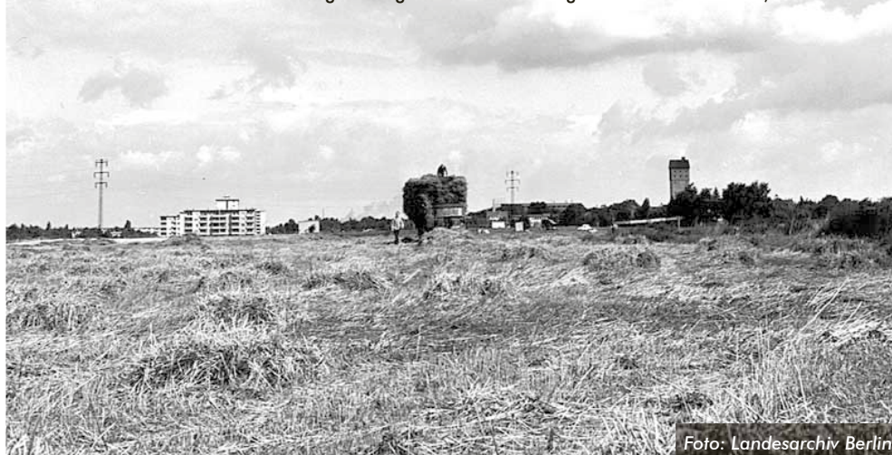
Letzte Feldarbeiten auf dem zukünftigen Baugelände der Siedlung Berlin Buckow-Rudow, 1962
