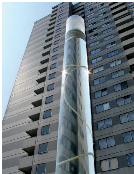
LINKS: DER FÜLLSTANDSMESSER VON GÜNTHER PEDROTTI IM RAHMEN DES PILOTPROJEKTS, 2002
