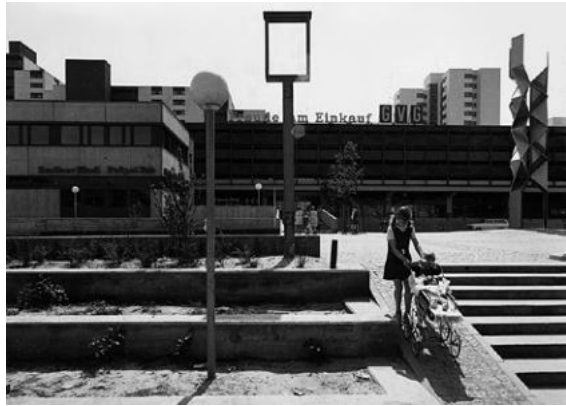
DAS „LADENZENTRUM SÜD“, IN DEN 1970ER JAHREN
