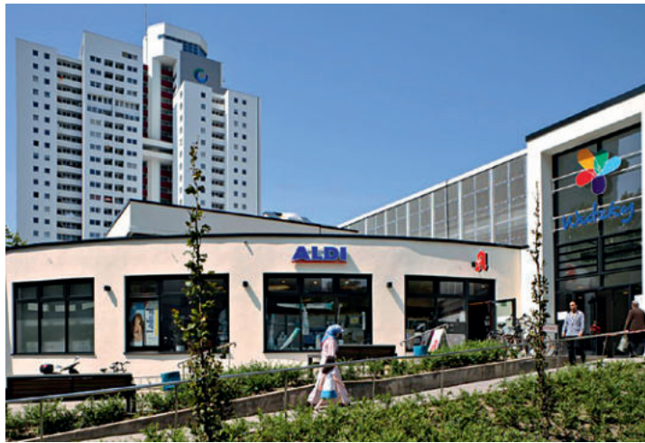
DAS NEUE WUTZKY-CENTER NACH DEM UMBAU, 2012
