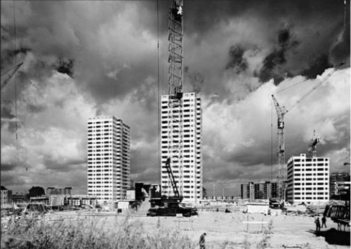
DREI 20-GESCHOSSIGE WOHNHOCHHÄUSER AN DER HUGO-HEIMANN-STRASSE, 1969
