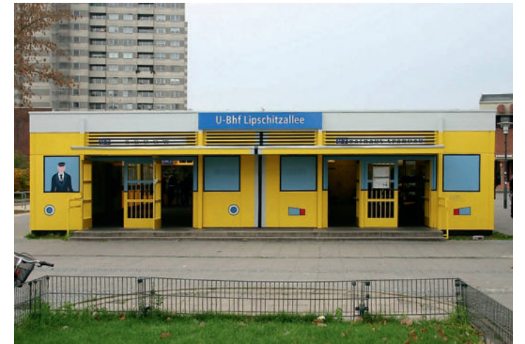
NEUER U-BAHN-EINGANG AM LIPSCHITZPLATZ, NACH UMBAU
