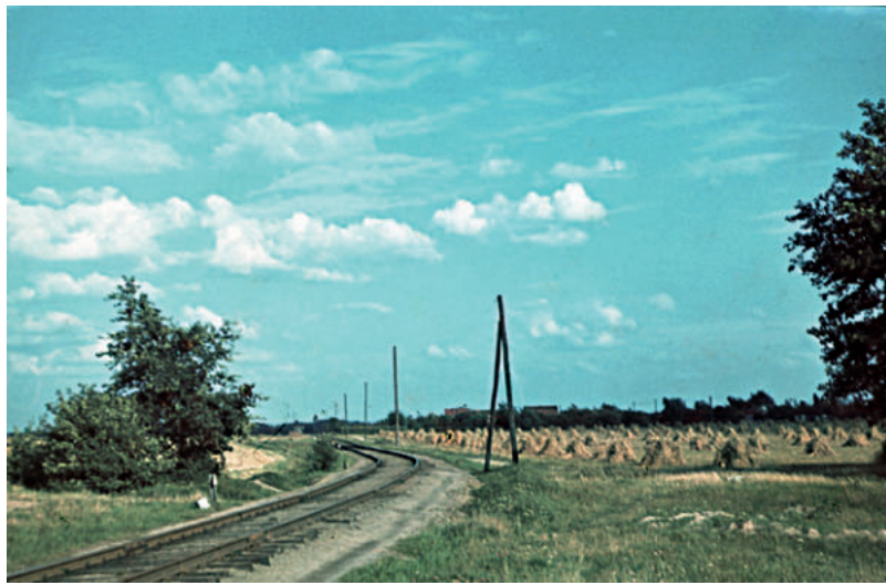
SCHIENEN DER NEUKÖLLN-MITTENWALDER-EISENBAHN
