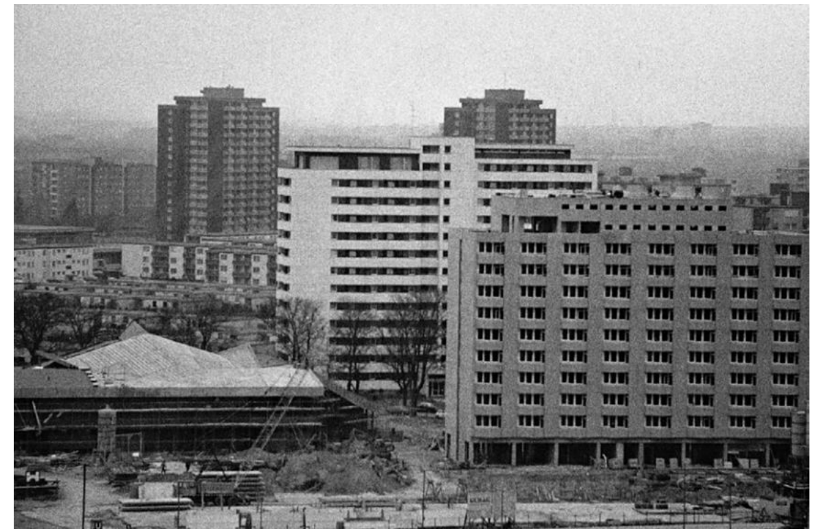
GEMEINSCHAFTSHAUS IM BAU
